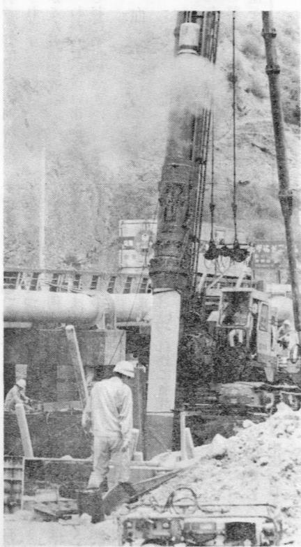
パイルの打ち込み作業この打ち込み時に発生する音は九十ホーンから百ホーン
