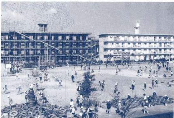
建設中の塩田団地（左）
