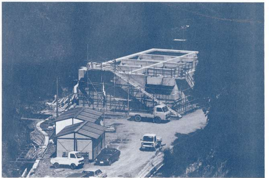
7月試運転をめざして 汚水処理施設を建設中
