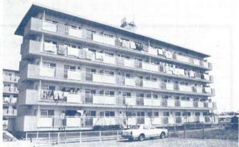
老人福祉センター(上)、財光寺北住宅(下)も完成しました
