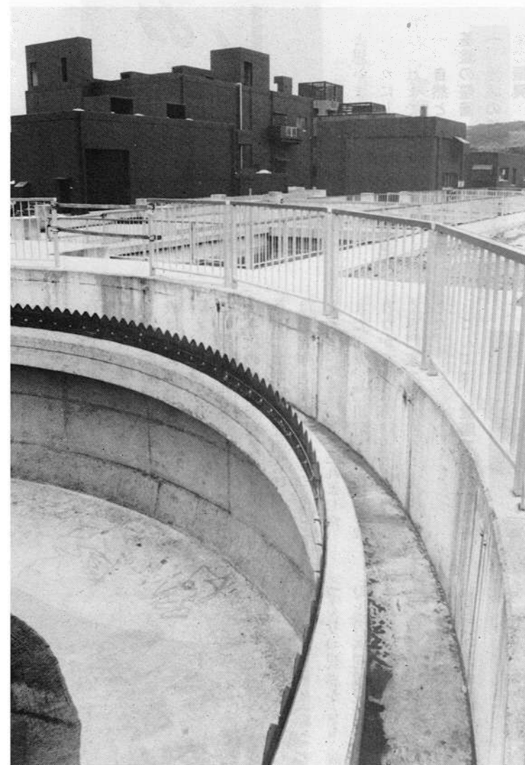
62年10月には一部の地域で運転を始めます。（財光寺下が浜に建設中の下水道終末処理場）
