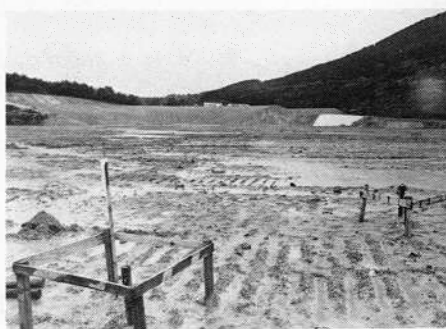
2期工事がスタート(多目的広場/米の山)
