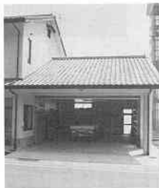
広くなった消防車庫
