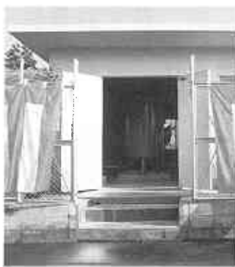
小原地区ポンプ場
