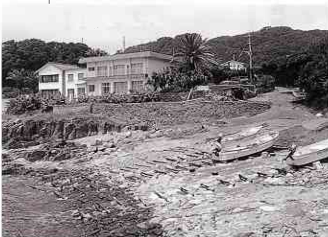
小船を引き上げるために敷き並べられた「コロ」
