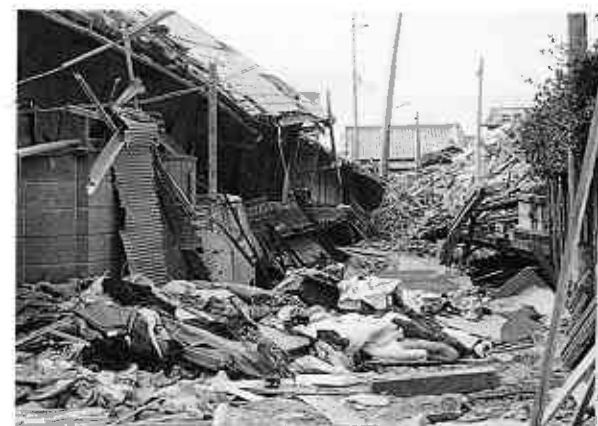
阪神淡路大震災直後の被害の状況
