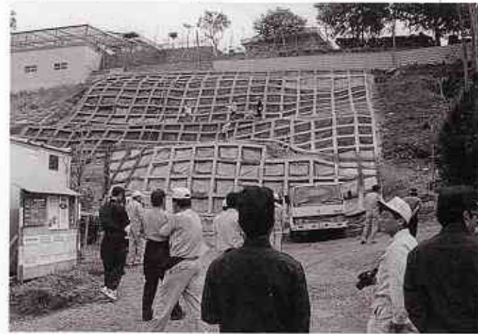
急傾斜地の工事を視察する総点検の参加者
