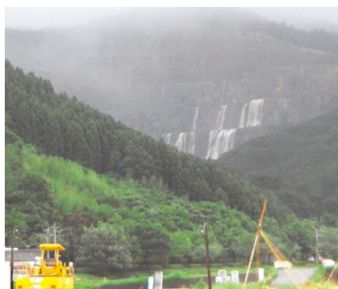
13日 13:09 財光寺木原 降り止まぬ豪雨。山の採石現場に滝が現れる。
