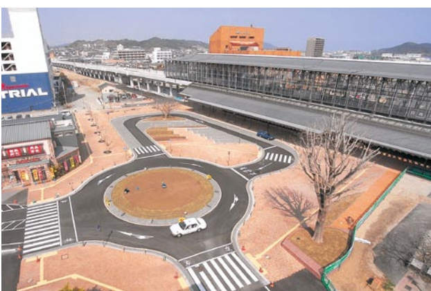
▲平成20年3月に完成した、JR日向市駅西口駅前広場
