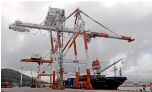
▲見上げるように大きなガントリークレーン、高さは50メートルを超える(手前が2号基)
