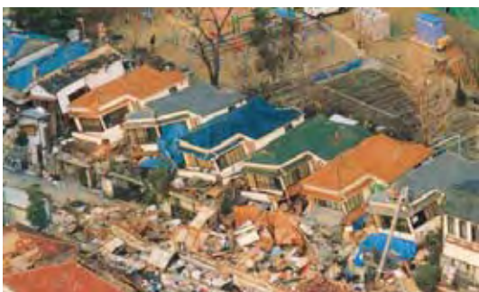
▲阪神・淡路大震災における住宅密集地の被害状況。隣棟との間隔が狭く、将棋倒しとなった家屋。
