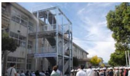
屋上避難スペースには合わせて1500人を収容。同校の全校児童数685人の倍以上の収容面積を確保。階段は大人数が短時間で移動することも想定し幅1.8m。階段と運動場周辺には夜間用の照明も設置してある。
