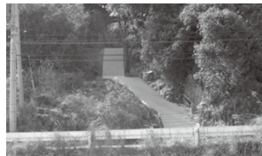
避難階段、一時避難場所の整備（美砂区）
