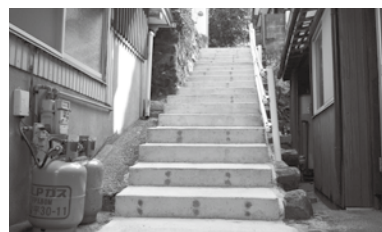
避難階段の改修（八幡区）
