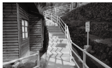
避難階段の改修（八幡区）
