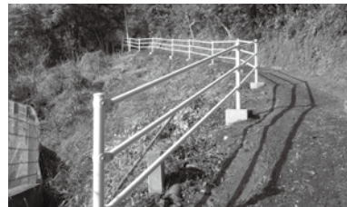
避難路の手すり設置（公園通り区）
