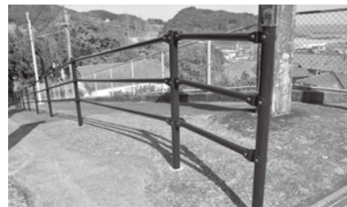
避難路の手すり設置（立縫区）
