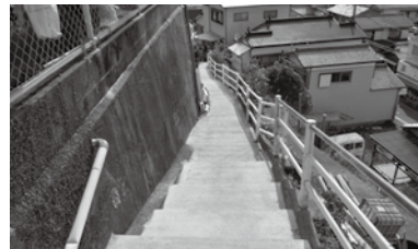
避難階段の改修（伊勢区）
