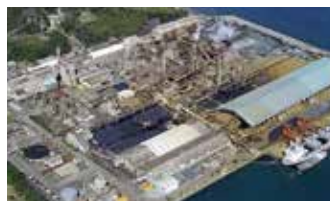
ステンレス鋼の原料となるフェロニッケル、天然砂の代替となるグリーンサンドを製造しています。
