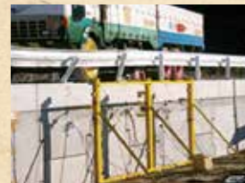
安全な強度を保ちつつ、省スペースでの道路建設を可能にしたL型擁壁。国からも認定を受けている。
