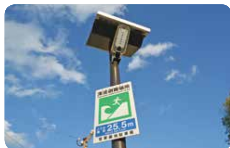
安全・安心なまちづくりに 停電時に安全に避難するため、LED 照明を設置するのに役立っています。
