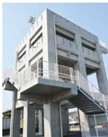
完成した避難タワー。往還タワー(写真上)は県内最大の920人を収容可能。2基ともに、組立式簡易トイレ、アルミ製ブランケットなどが備蓄されている。
