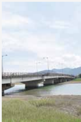
たいといばし 大瀛橋（平成6年建設）
