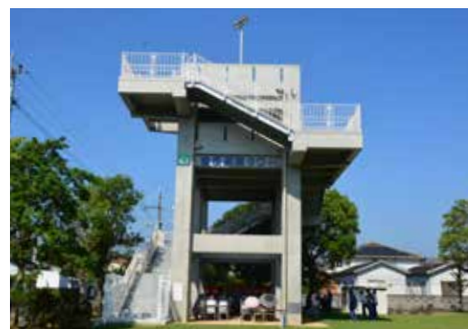
曾根街区公園に完成した曾根避難タワー
