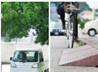
道路にはみ出した庭の枝木や段差解消のための乗り入れ板は、車やバイクなどの事故の要因になり大変危険です。
