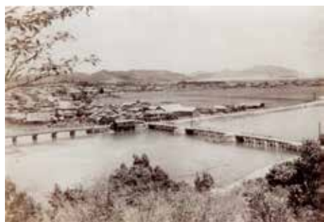
賀来飛霞も見た塩見橋(右側の橋、昭和10年頃、『日向写真帳』より転載)
