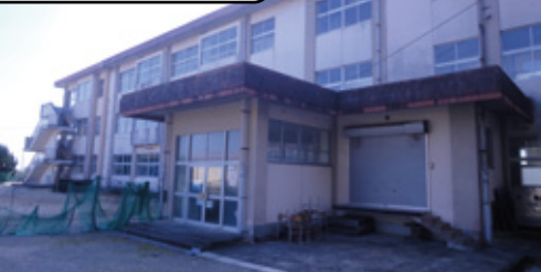
令和4年度に校舎の解体を行いました。今年度は、体育館などの解体を予定しています。
