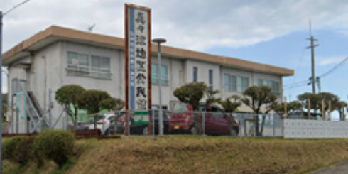
令和6年度に耐震補強工事を行います。
