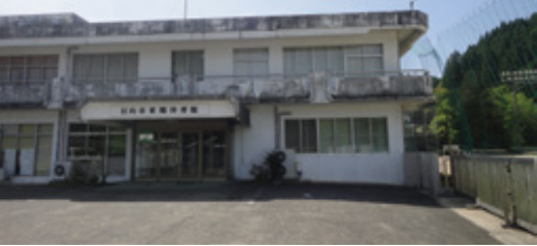
今年度に耐震補強工事を行います。
