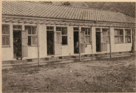
完成した第二病棟 (東郷直営診療所)
