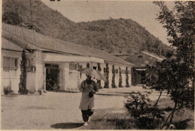
村立東郷病院（本館と伝染病棟）
