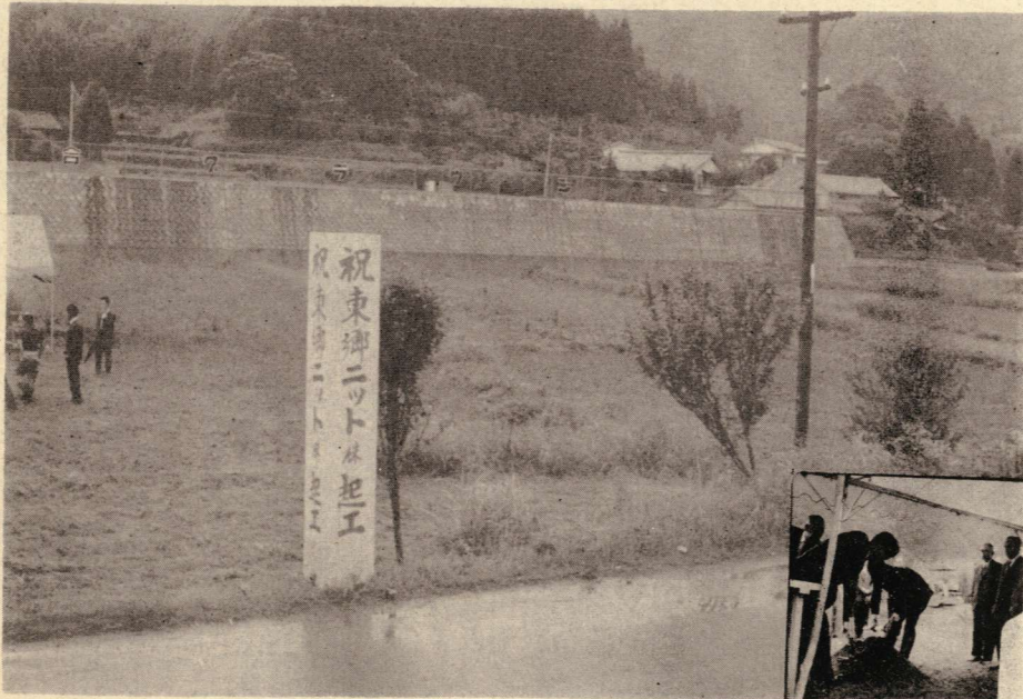
写真は ニット工場用地と起工式 (右下)
