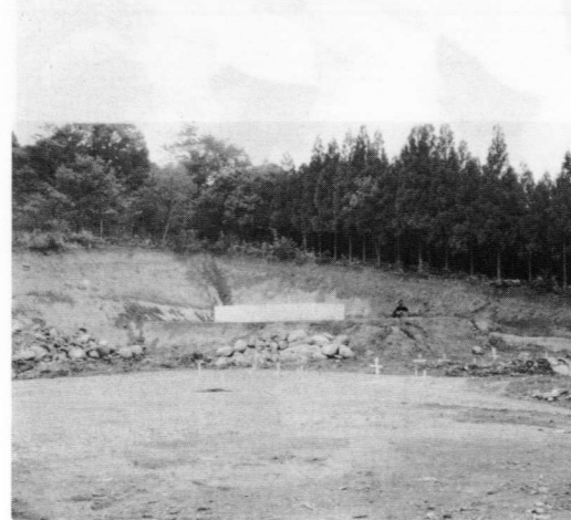
▲813トンの貯水量を備えた浄水場(仲崎に建設中)
