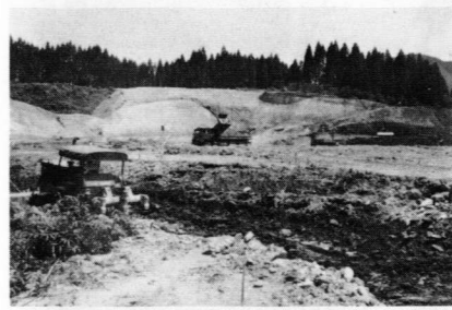
耳川流域の国産材流通加工施設建設のための用地造成が行われた
