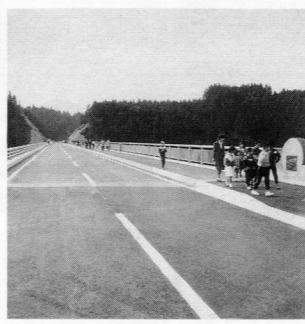
完成した東郷大橋
