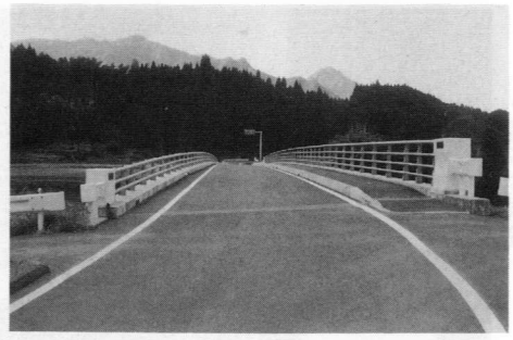
羽坂農免道路新羽坂橋
