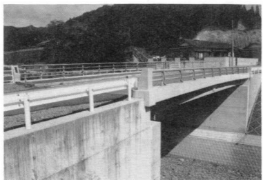
▲改良された大谷橋
