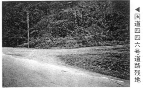
◀国道四四六号道路残地
