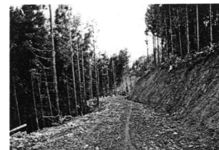
▶開設された作業路
