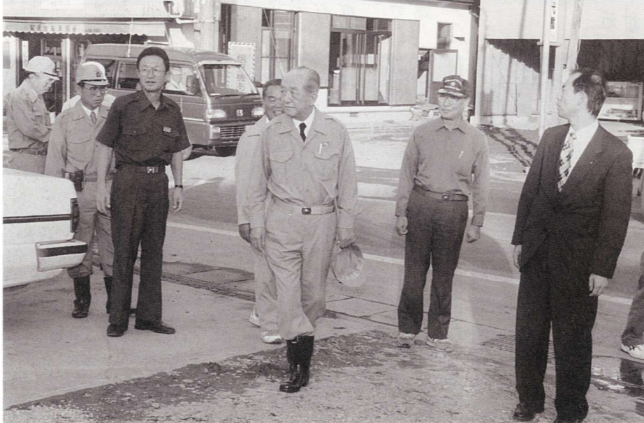
▲被災世帯の状況を視察される松形知事
