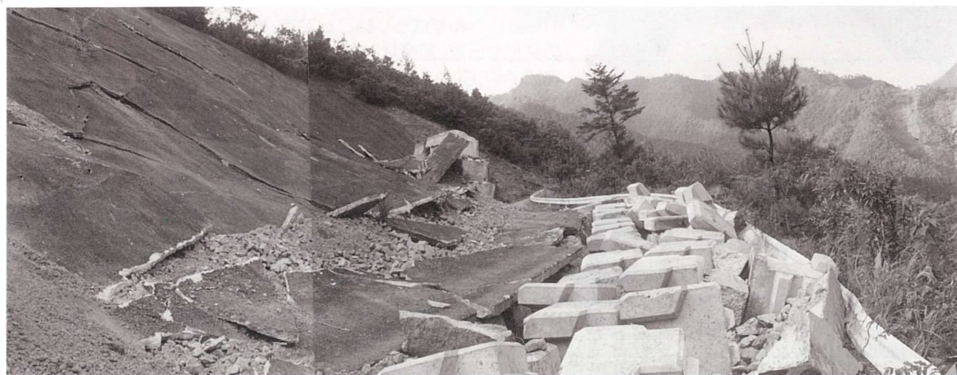
▲土砂崩れにより通行不能となった町道越表橋～下渡川線
