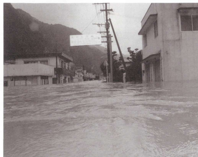
▲役場下の国道
