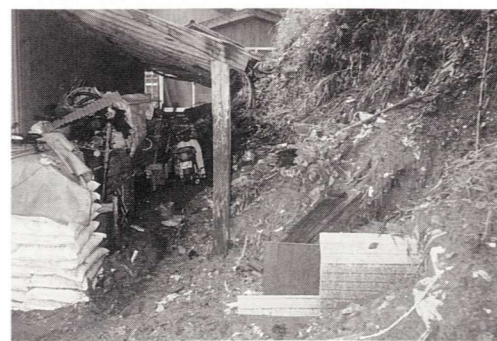
▲台風で裏山が崩れ倉庫に土砂が押し寄せた
