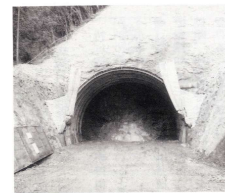
▲着工となったトンネル(越表側)
