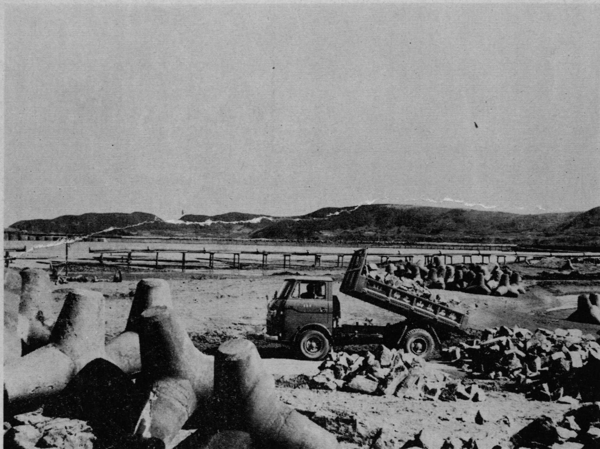
写真は……急ピッチで埋めたてられる工場用地
