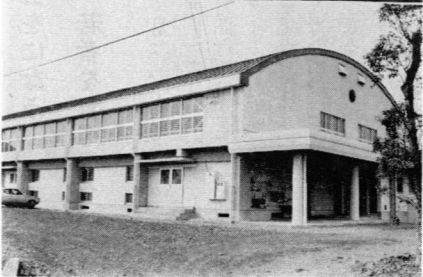
美々津小体育館
