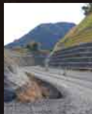
門川～日向IC間工事発注率は100%。写真は日向IC付近。
