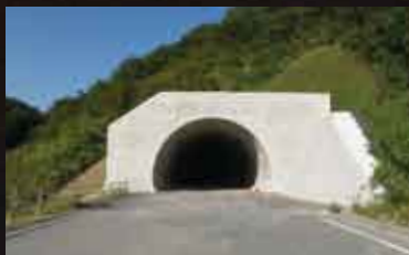
日向第2トンネル工事(L＝1.8km)はすでに竣工。日向第1トンネル工事(L＝1.3km)進捗率98.6% (H21.11月末現在)。
