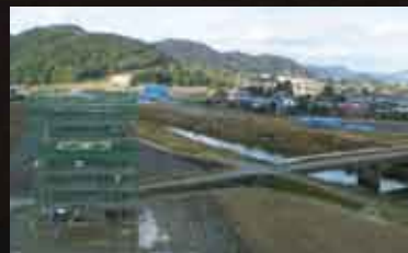
赤岩川にかかる橋梁の「下部工」工事。車両が走る「上部工」、橋を支える「基礎工」で成り立つ。
