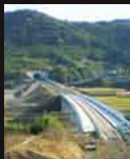
塩見城跡から瀬ノ口トンネルを望む。権現原 C-Box も開通。
