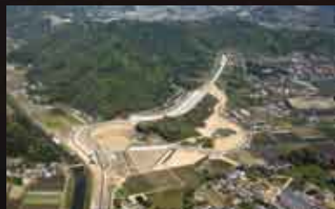
財光寺地区の日向インターチェンジ(L＝1.8km)工事はすでに竣工。
