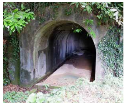
地蔵山麓の電波探信儀隊用発電所跡
