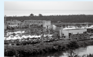
津波により浸水した下水処理場
